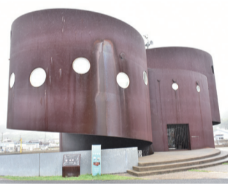
福良港津波防災ステーション
